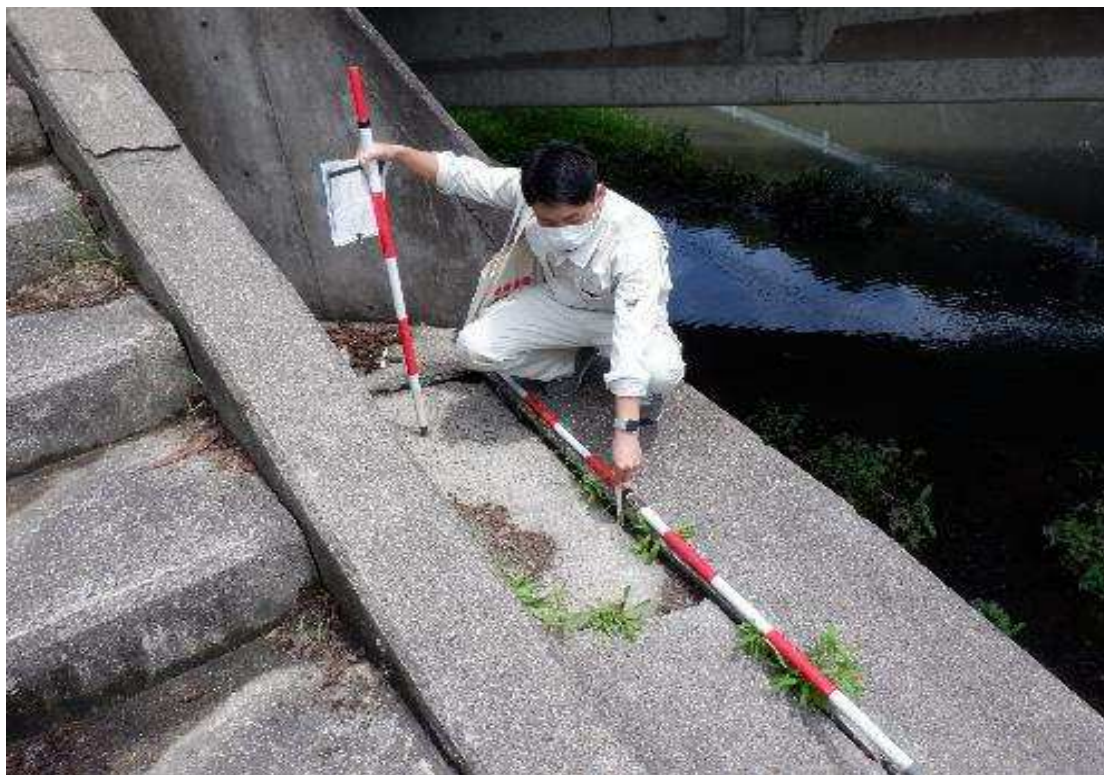
R3定期点検(山南川)
