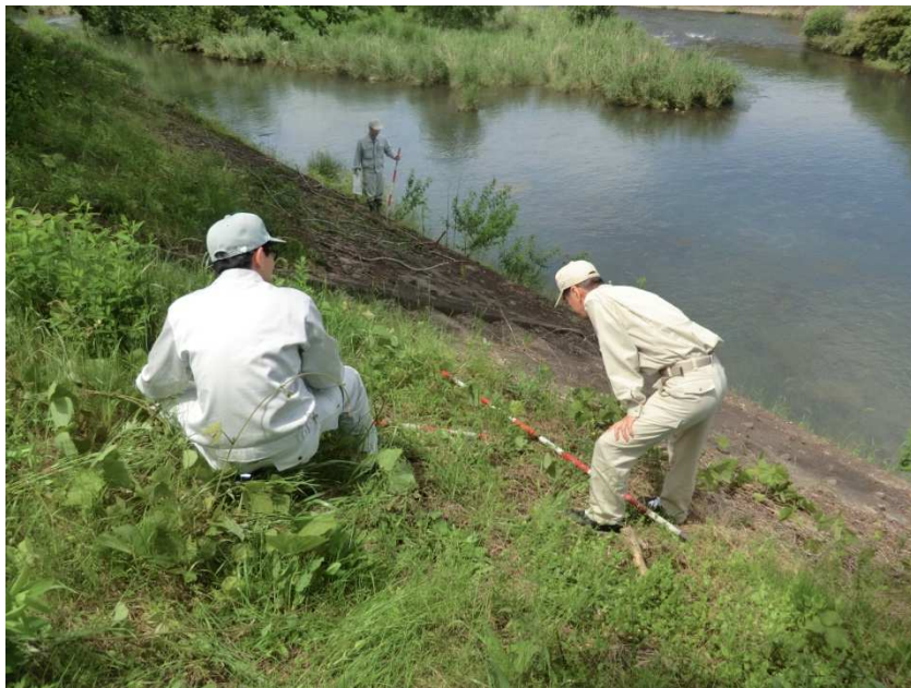
堤防点検の様子（馬洗川）
